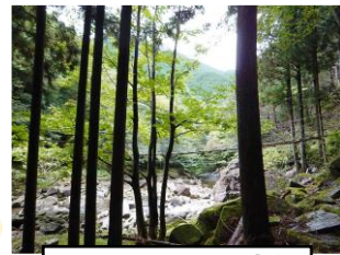
搭ノ谷 吊り橋
