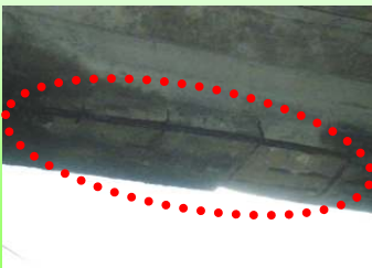
主桁の損傷（鉄筋露出）
